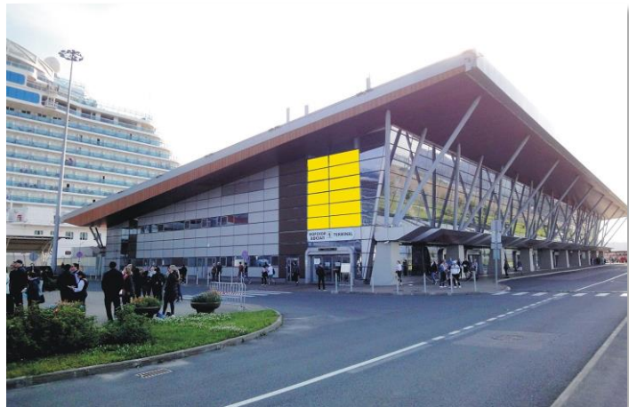
Оклейка остекления над входом в терминал
